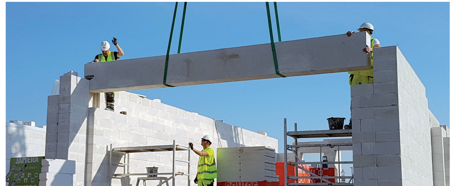
Kuvassa 600 mm kevytbetonipalkin asennus. Aukon maksimi leveys 6000 mm palkilla on 5 400 mm.
